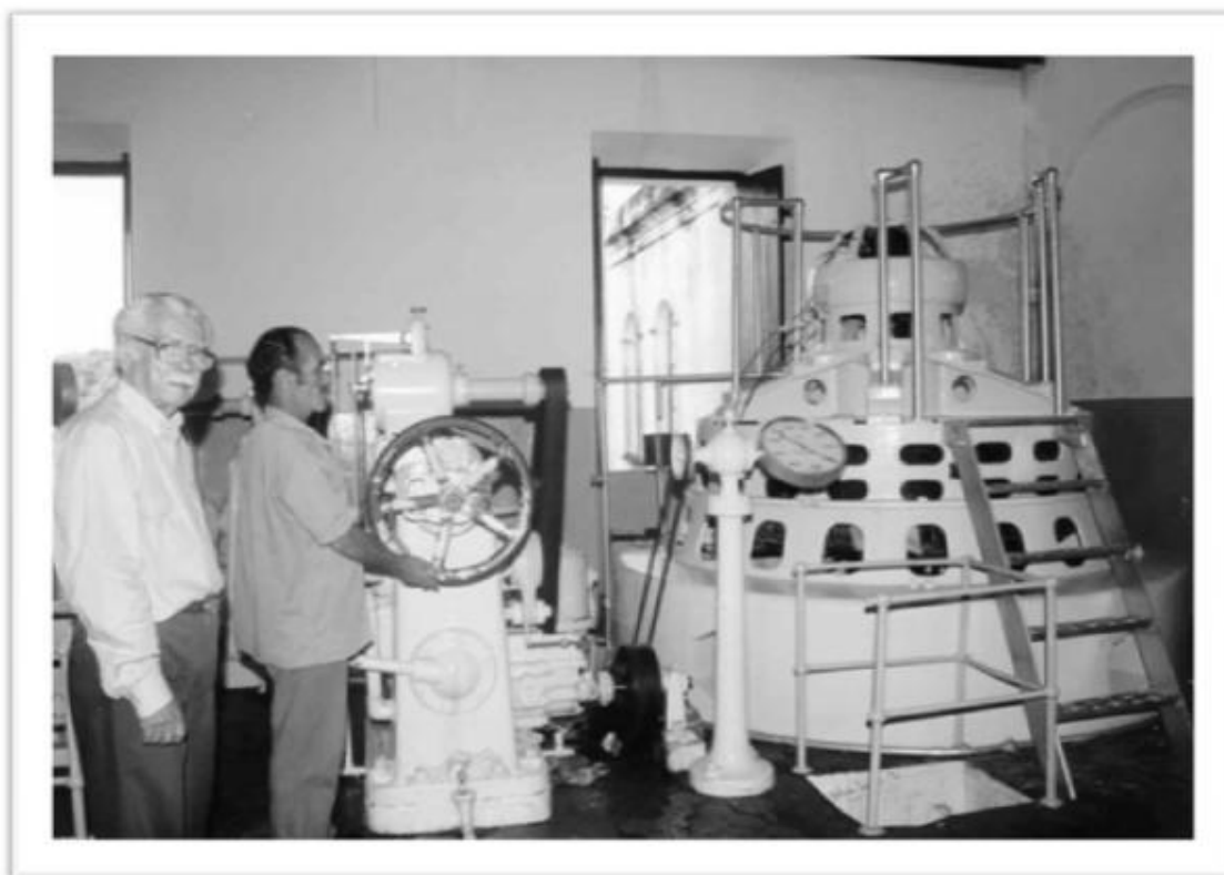
Diretor-Presidente Engº Jorge do Prado Leite na turbina que fazia o aproveitamento hídrico do Rio Piauí.
